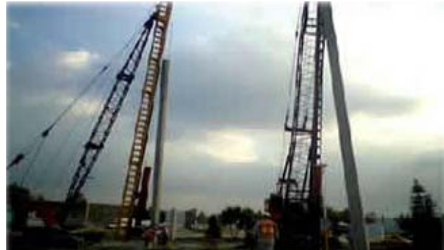
Figura 1.- Proceso de hinca pilotes prefabricados.
