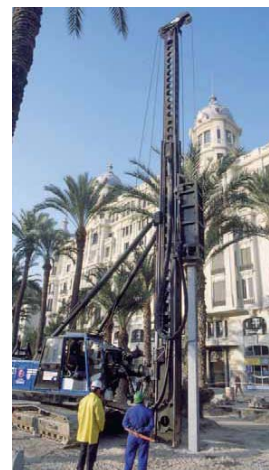
Figura 6.- Ejecución pilote.
